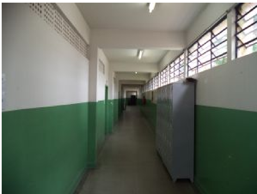
Figura - Corredores das salas de aula
