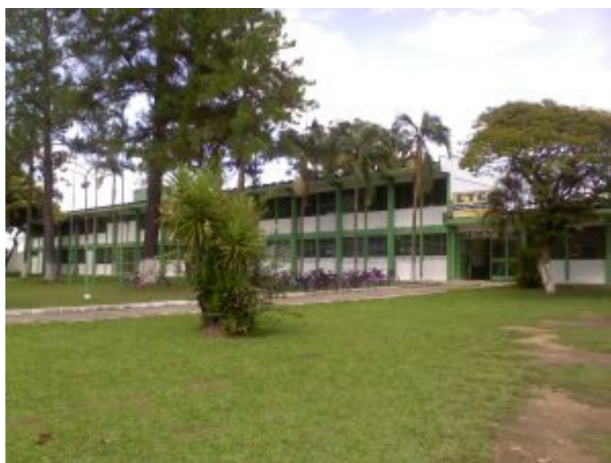
Figura – Fachada da escola pintada
