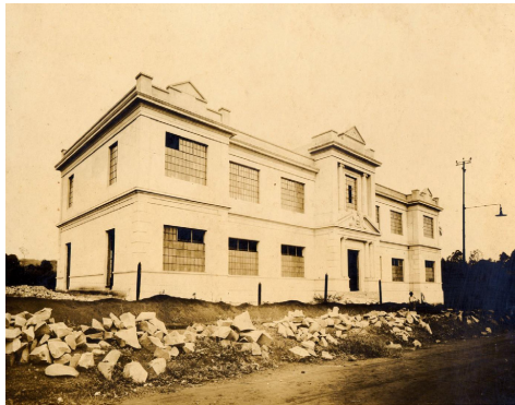
Escola Profissional José Martimiano da Silva, fachada e lateral do prédio, 1927. Foto Rainero Maggiori. APHRP.
