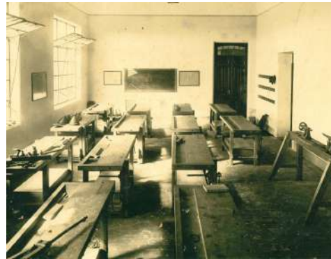
Sala de aula da Escola Profissional José Martimiano da Silva, 1927. Foto Aristides Motta & Maggiori. APHRP.
