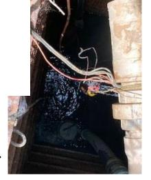
Duas bombas de esgoto submersíveis ->
