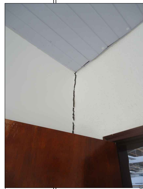
Rachadura no canto do ambiente com altura do Pé-direito
