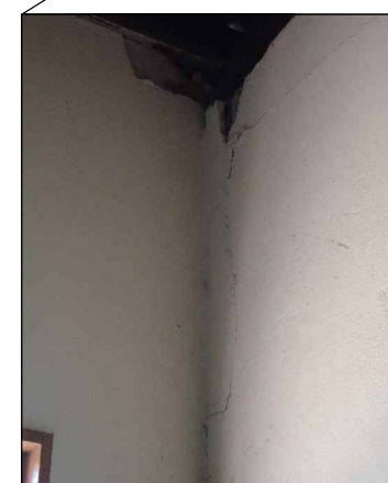
Rachadura no canto superior do ambiente
