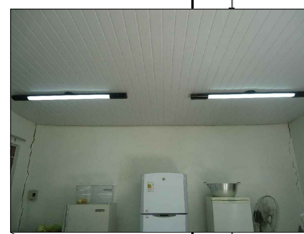
Rachadura no canto do ambiente com altura do Pé-direito
