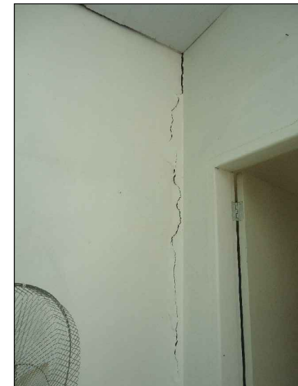
Rachadura no canto do ambiente com altura do Pé-direito
