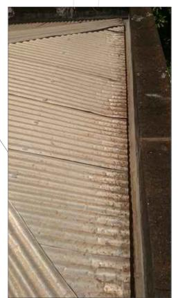
Cobertura em telha metálica ondulada
