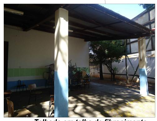
Telhado em telha de fibrocimento ondulada
