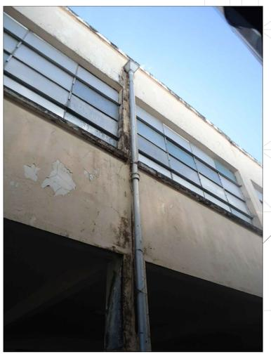
Tubo de queda de água pluvial
