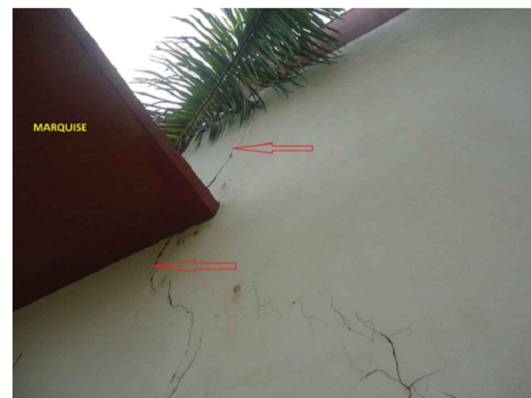
FOTO 1 - JUNTA DE DILATAÇÃO NA MARQUISE
