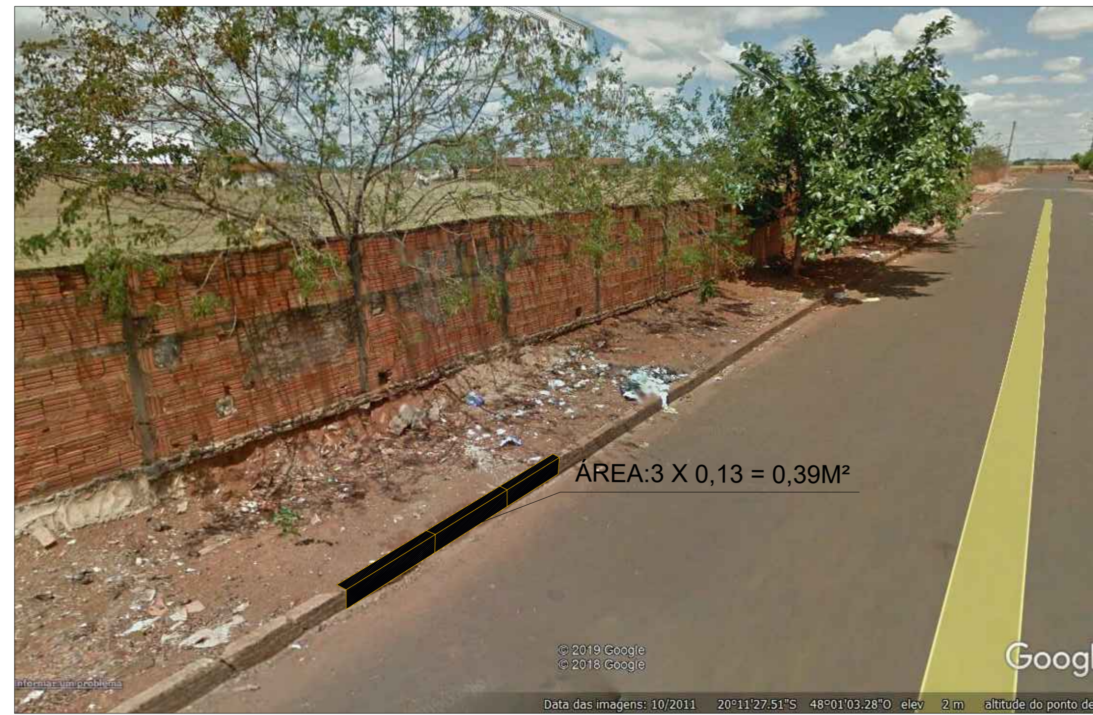
LOCAÇÃO DA GUIA A SER CONSTRUÍDA:
