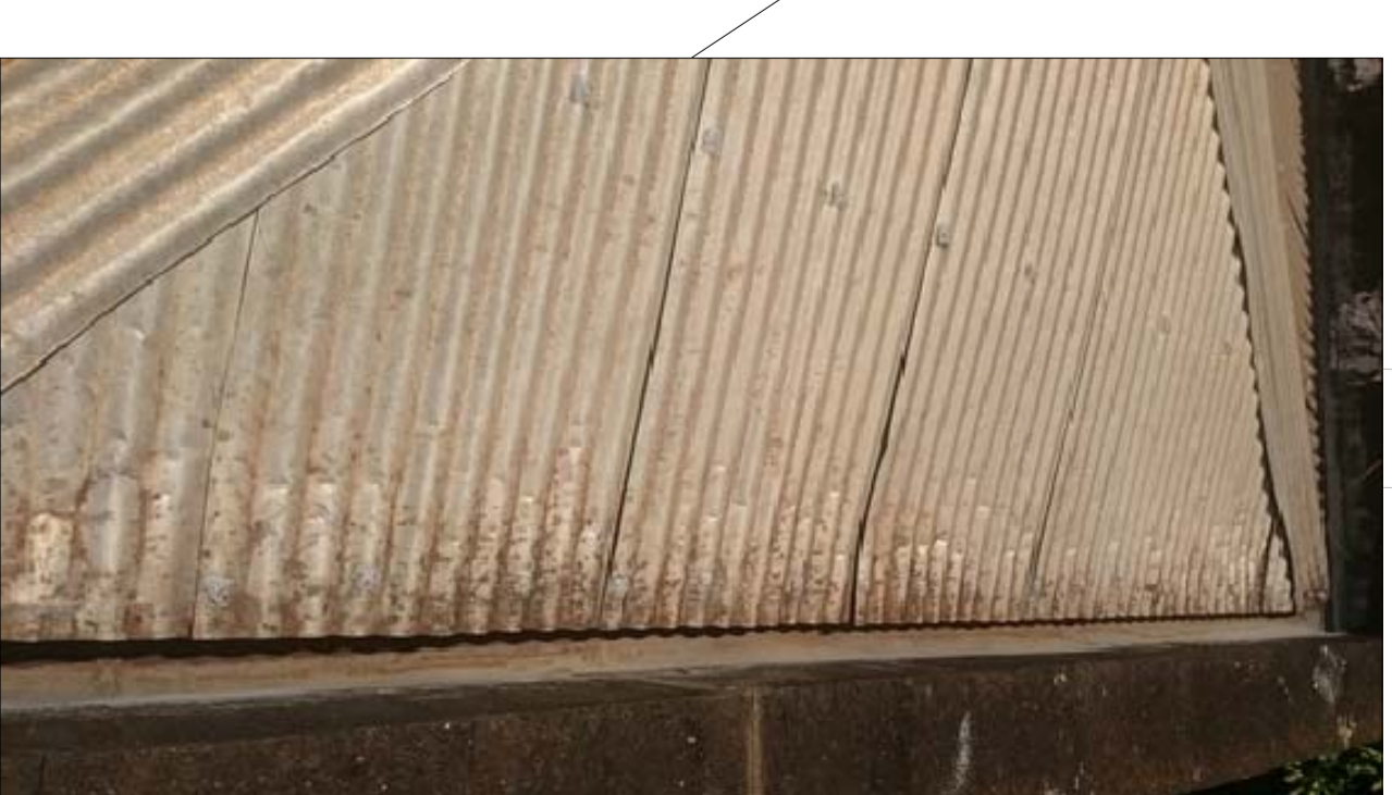
Cobertura em telha metálica ondulada
