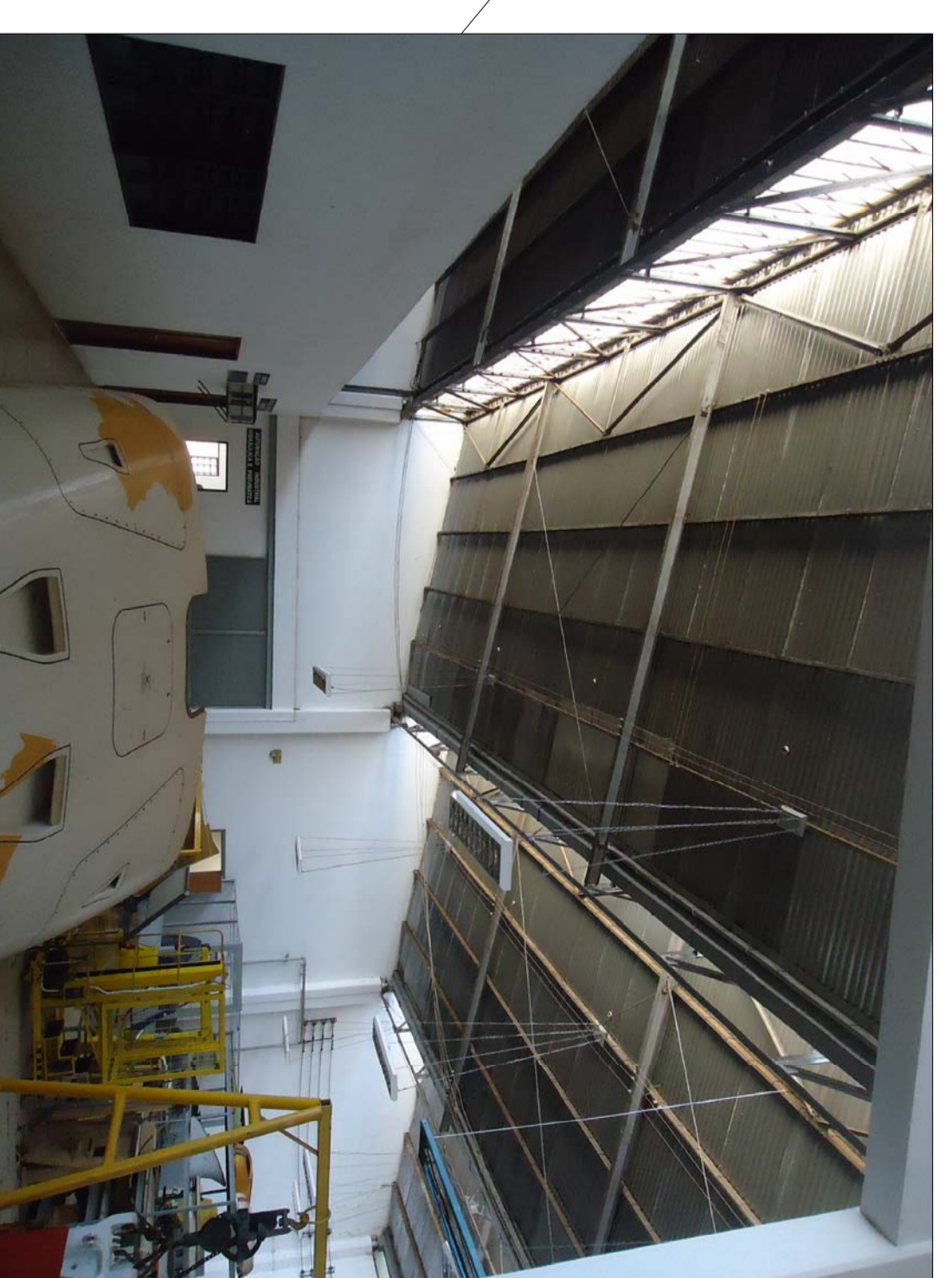
Cobertura (SHED) em telha sanduíche e luminárias
