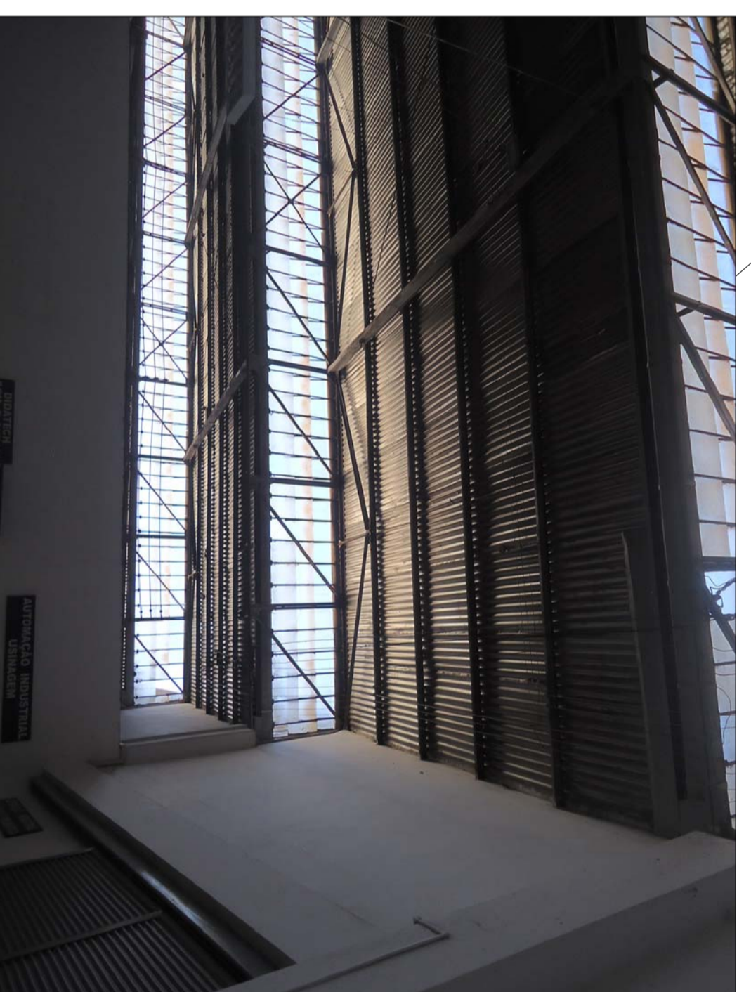
Shed com vidro
