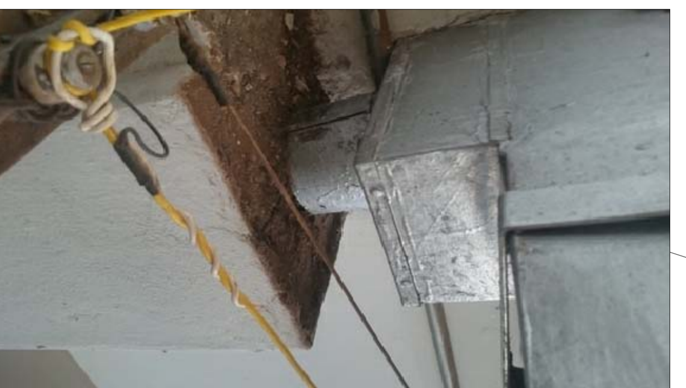
Calha e Tubo de queda
