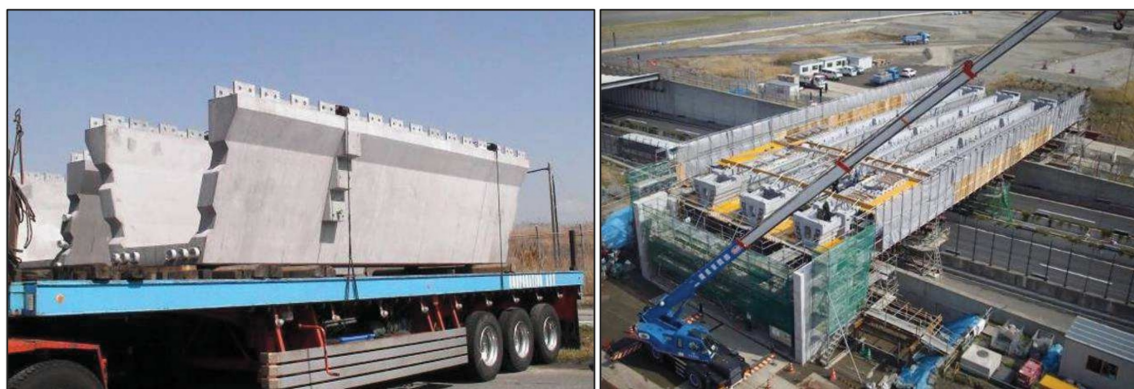
Figura 3 - Peças (e montagem) e ponte onde estão aplicadas
