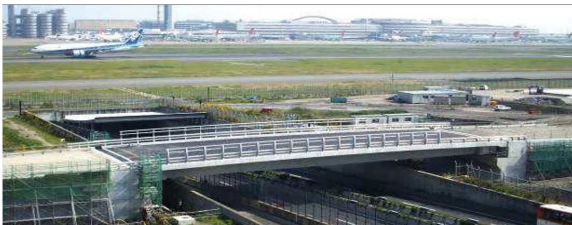
Figura 2 - Ponte no aeroporto de Tóquio
