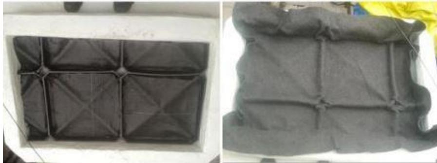
**Figura 5:** Posicionamento dos módulos plásticos e manta geotêxtil.
