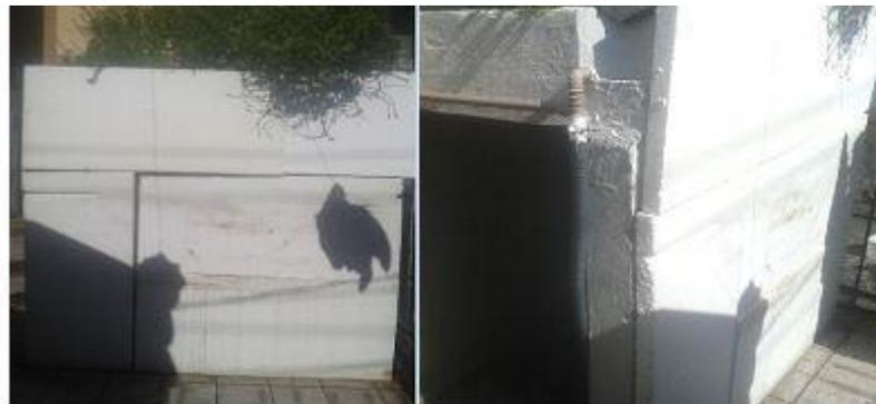
**Figura 8:** Posicionamento placas de isopor
