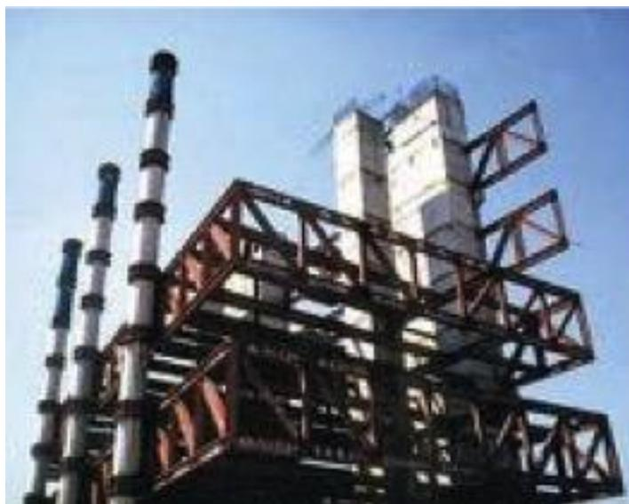
Figura 2. Edifício da FATEC Tatuapé na fase dos 17 anos de abandono, de onde se observam os elementos estruturais que são os 3 pilares de concreto à frente e as duas torres de elevadores na parte de trás da edificação, além das vigas projetadas no sistema Vierendeel.
