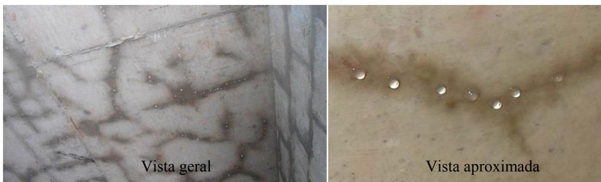
**Figura 6- Fissuras típicas da retração por secagem.**
