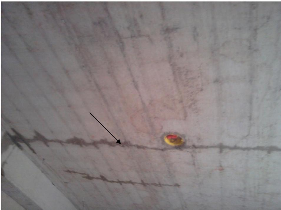
**Figura 25- Fissura em toda extensão do vão da laje**
