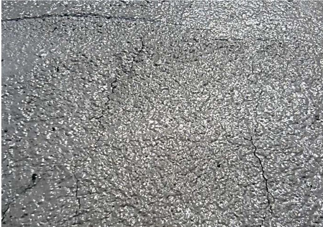
**Figura 20- Fissuras de retração plástica na laje maciça B.**
