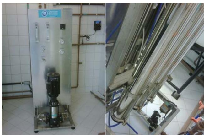
Figura 2: Equipamento de osmose reversa em sala de tratamento de água - Campinas
