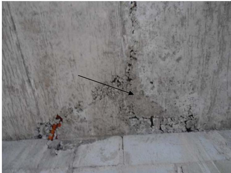
Figura 30- Fissura oriunda do eletroduto e adensamento incorreto
