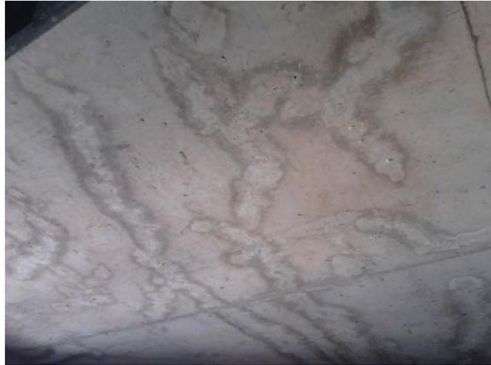
**Figura 26- Fissuras da retração por secagem e manchas na laje causadas pela lixiviação.**
