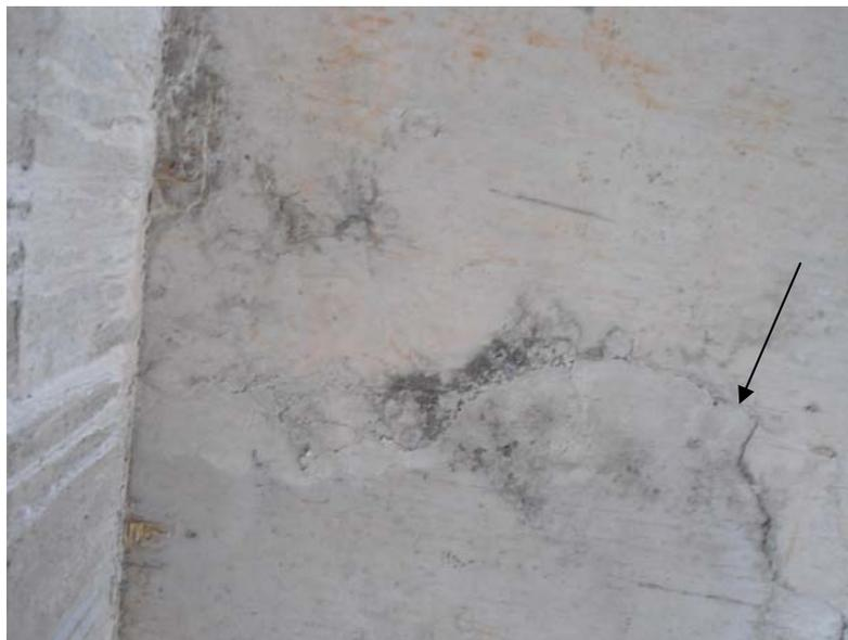
**Figura 29- Fissura causada por execução de junta de concretagem**
