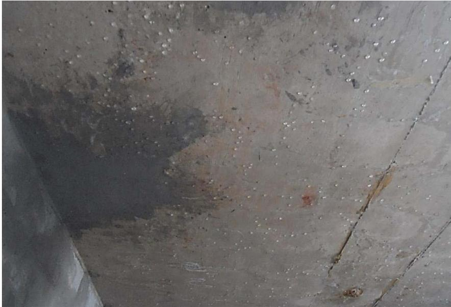
**Figura 18- Face interna da laje com gotejamento**
