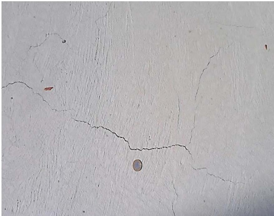
**Figura 17- Fissuras superficiais característica da retração plástica**
