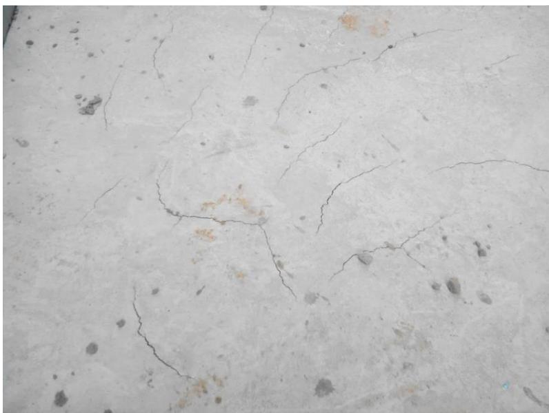
Figura 3- Fissuras típica de retração plástica
