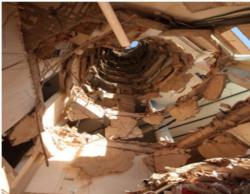
Figura 1- Desabamento das lajes do edifício senador.
