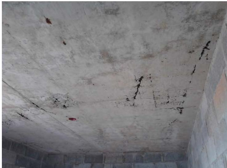
**Figura 27- Patologias denominadas "Bicheiras" causadas pelo adensamento inadequado**
