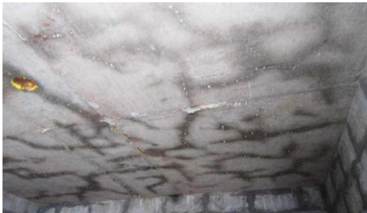
**Figura 19- Face interna da laje com fissuras com aspecto de mosaico**
