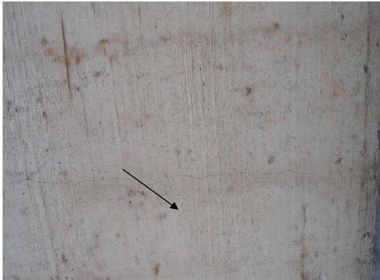
**Figura 28- Fissuras destacadas no centro da laje da área comum**
