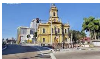
Estação do Metrô Santo Amaro
