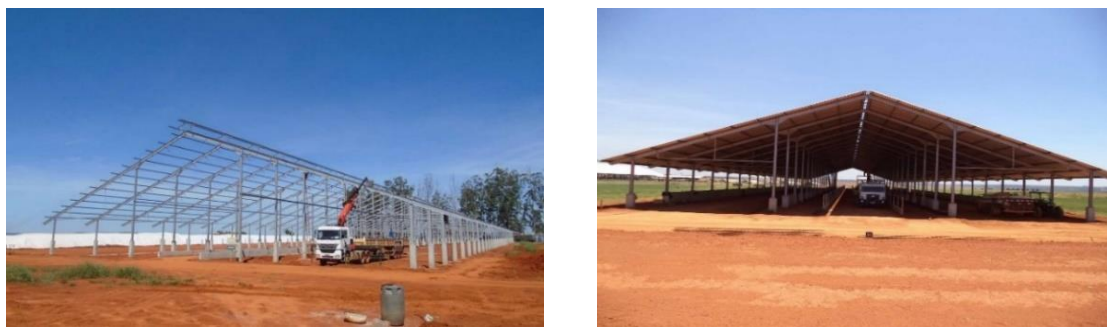
Figura 2: Etapas da construção do Compost Barn
