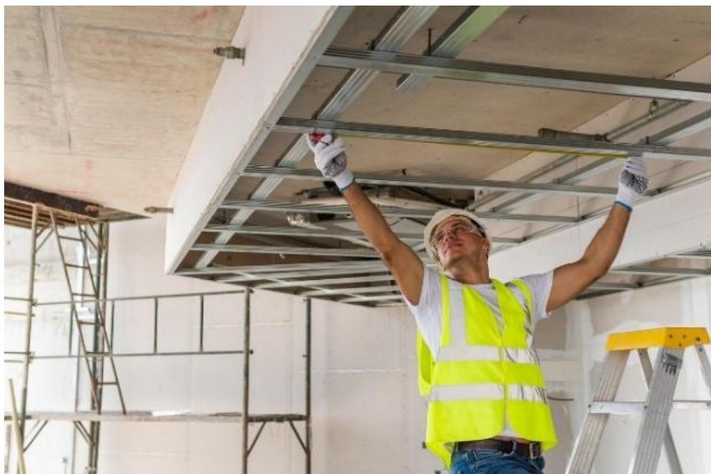
Figura 10: trabalho em altura utilizando escada móvel (Foto: Pixabay)
