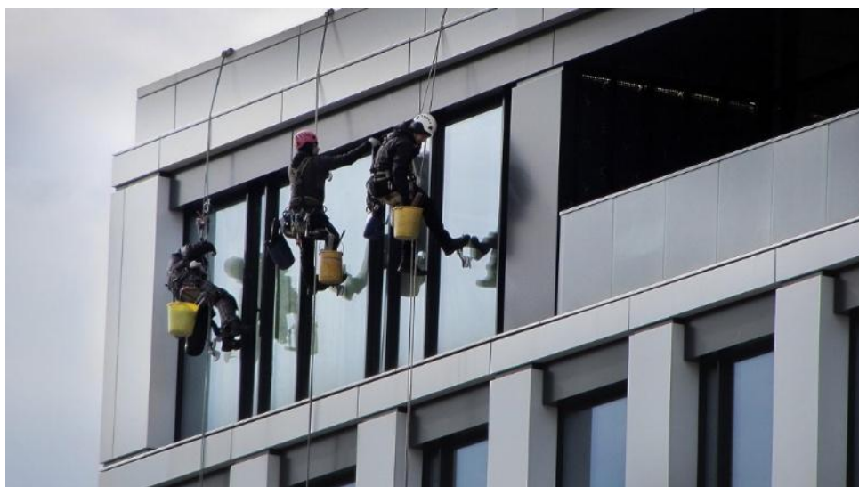
Figura 12: limpeza de fachada em cadeirinha (Foto: Pixabay)
