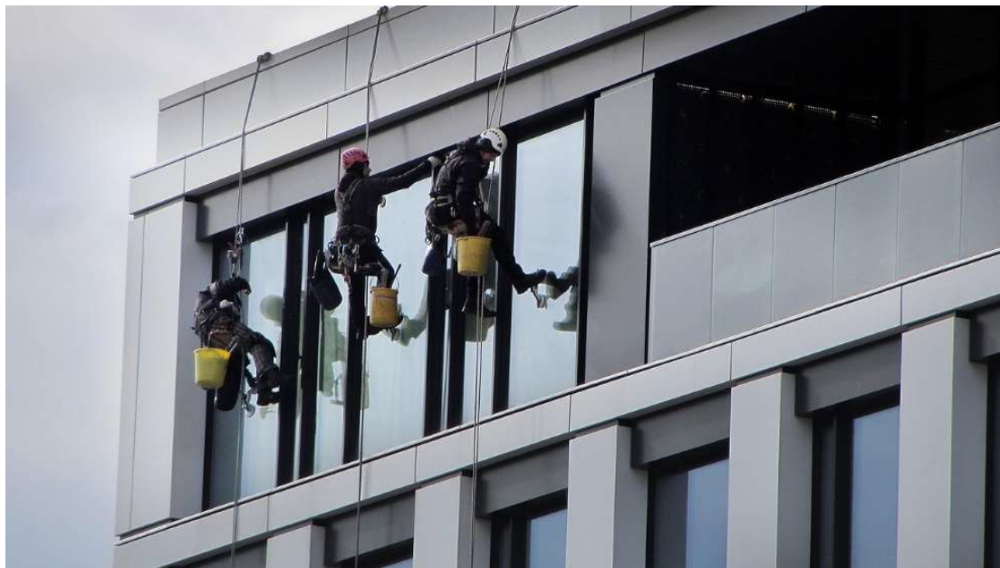
Figura 15: limpeza de fachada com cadeirinha
