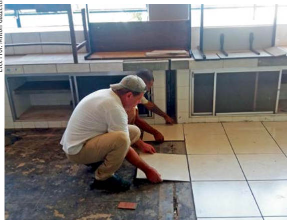
Reeducandos em prática de assentamento de piso no prédio 2 da Etec de Presidente Venceslau
