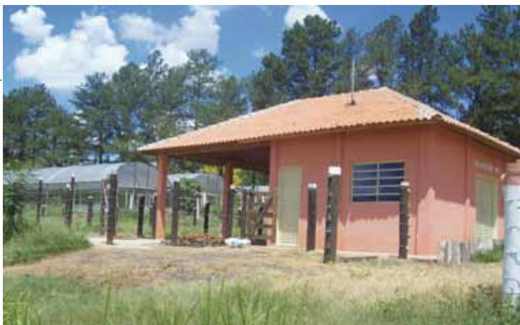
Etec de Mirassol: construção de sala de ordenha e compra de gado leiteiro
